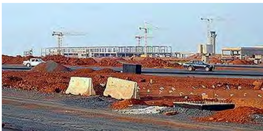
Figure 15.4 : Vue des travaux de construction de l'AIBD 56
